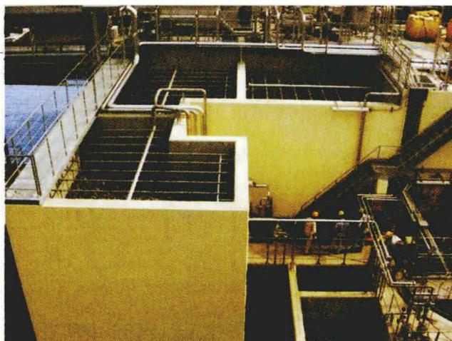
**吉** 原製油株式会社と日立製作所は、製油工場から排出される排水（油を高濃度に含有）を直接生物処理するシステムを共同で開発した。このシステムの300 m<sup>3</sup>/d実用プラントが、吉原製油株式会社神戸工場に完成した。
