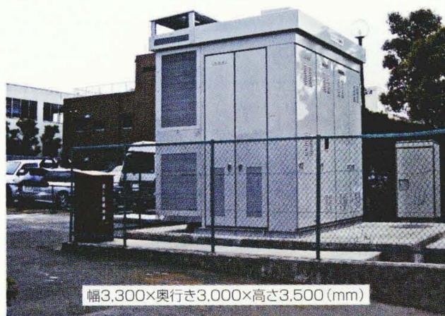
**都**市部のように電力需要の高密度化が進んだ地域で、6 kV負荷を22 kV配電系統に吸収する目的で大容量・コンパクト・環境適合を特徴とする22/6 kV配電塔(10 MVA)を東京電力株式会社と共同で開発し、初号機を同社の大田支社に納入した(大井31号配電塔)。
