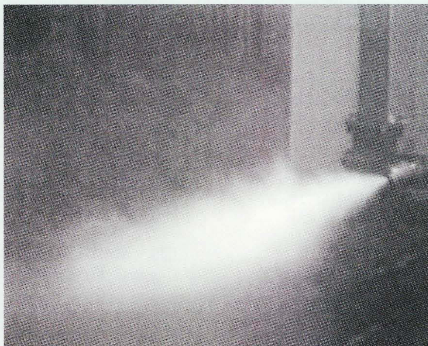
(b)ウォータージェットピーニング施工状況
