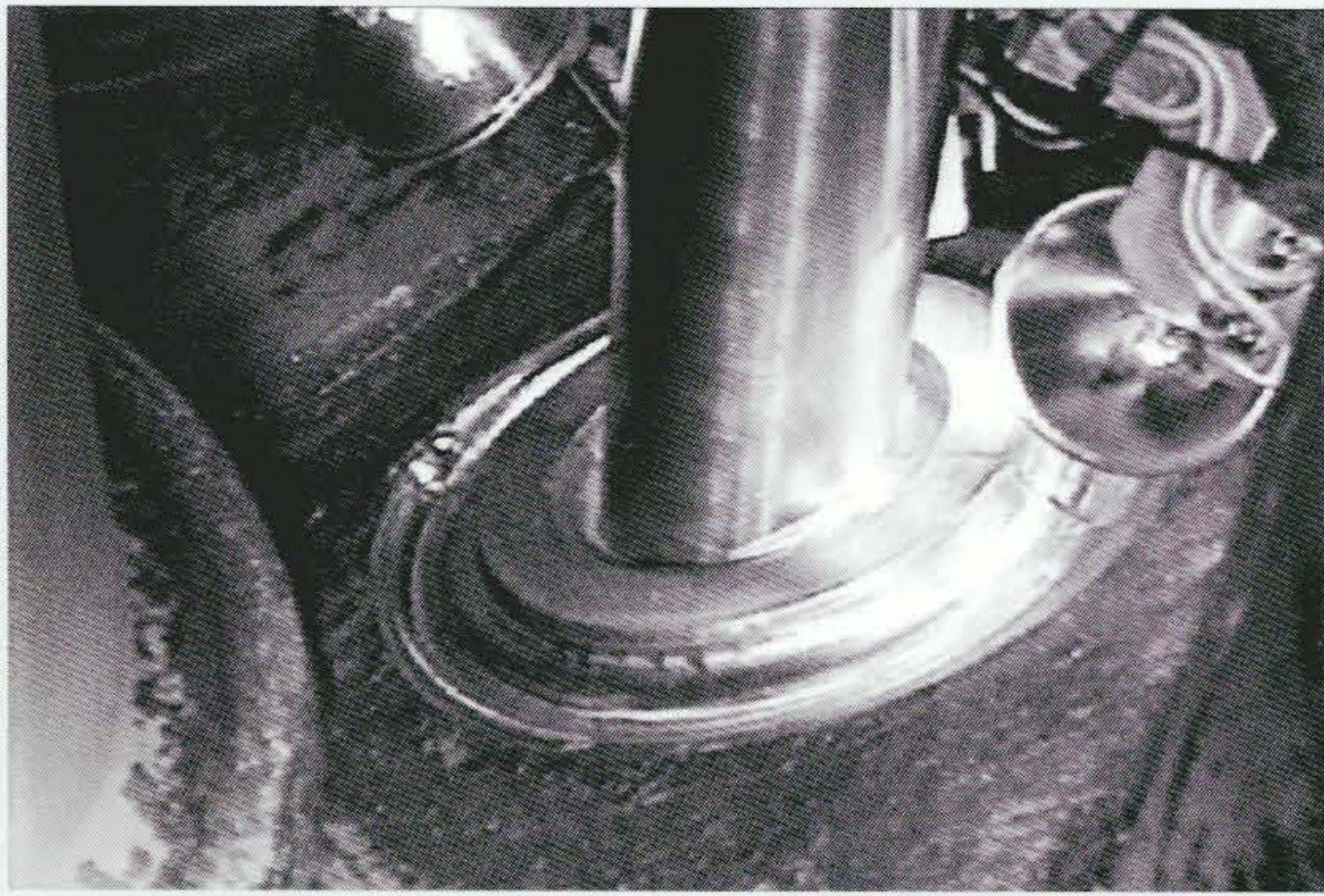
図11 新ICMハウジングと原子炉圧力容器溶接部 遠隔の三次元溶接技術と監視技術を適用した。
