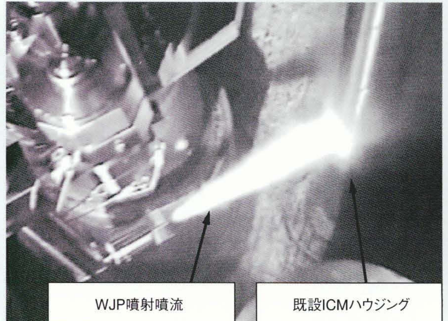
図12 WJPの実機への施工状況
