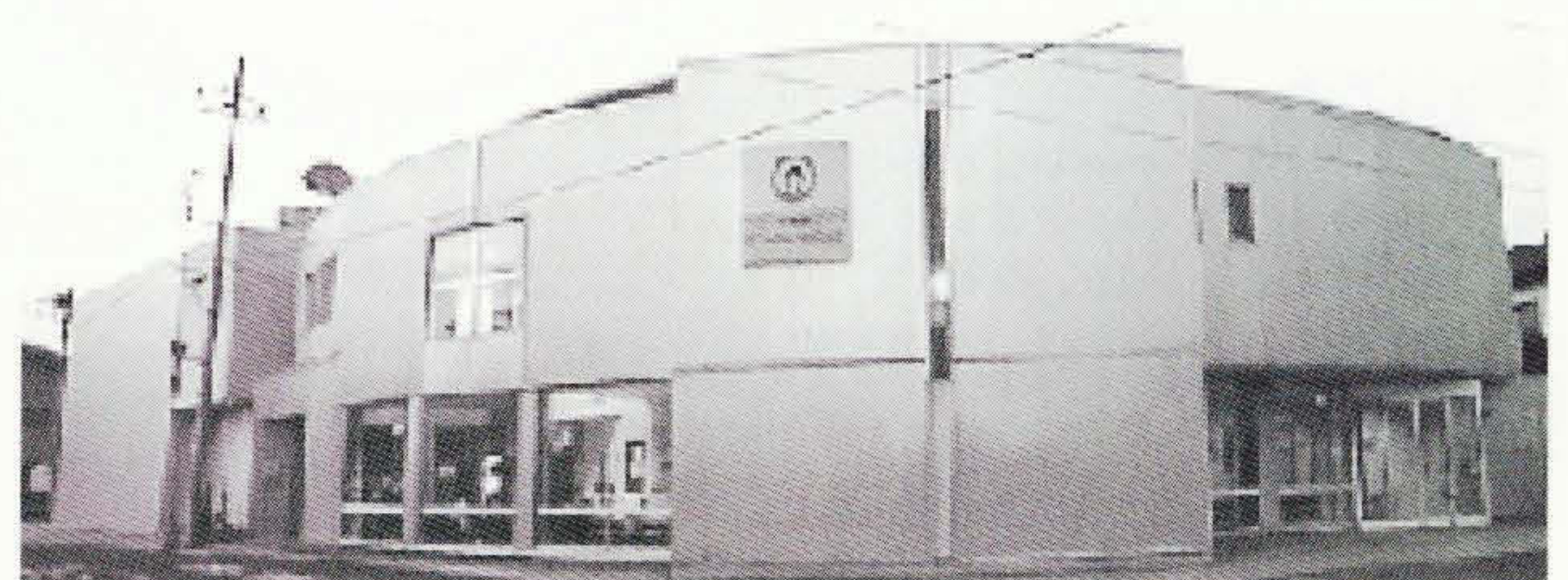
図4 宇都宮セントラルクリニックPETセンターの外観
