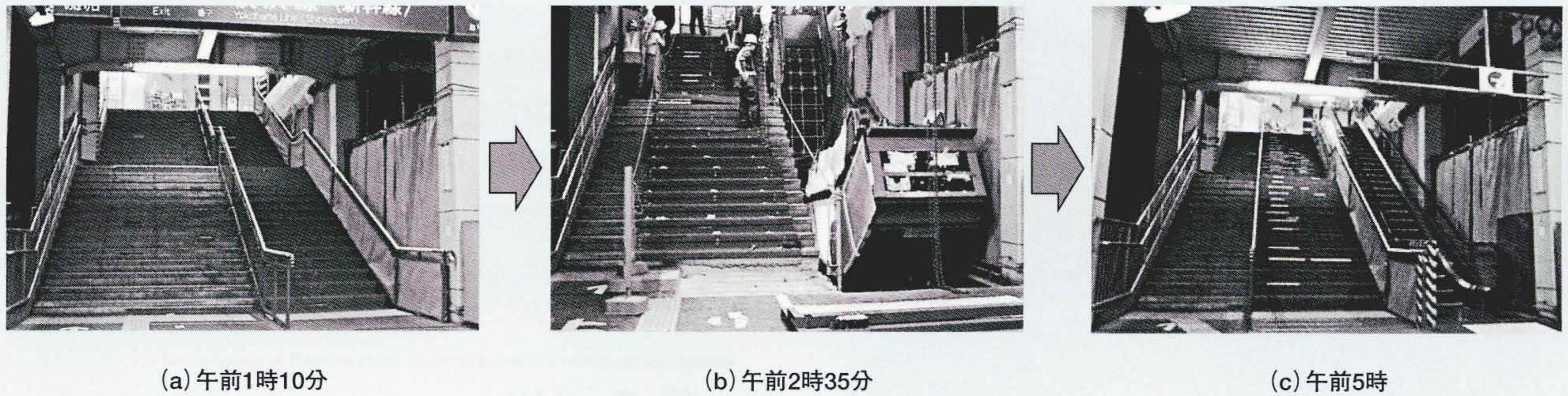
図3 超短期設置工法によるエスカレーター設置工事(東急東横線菊名駅での例)
