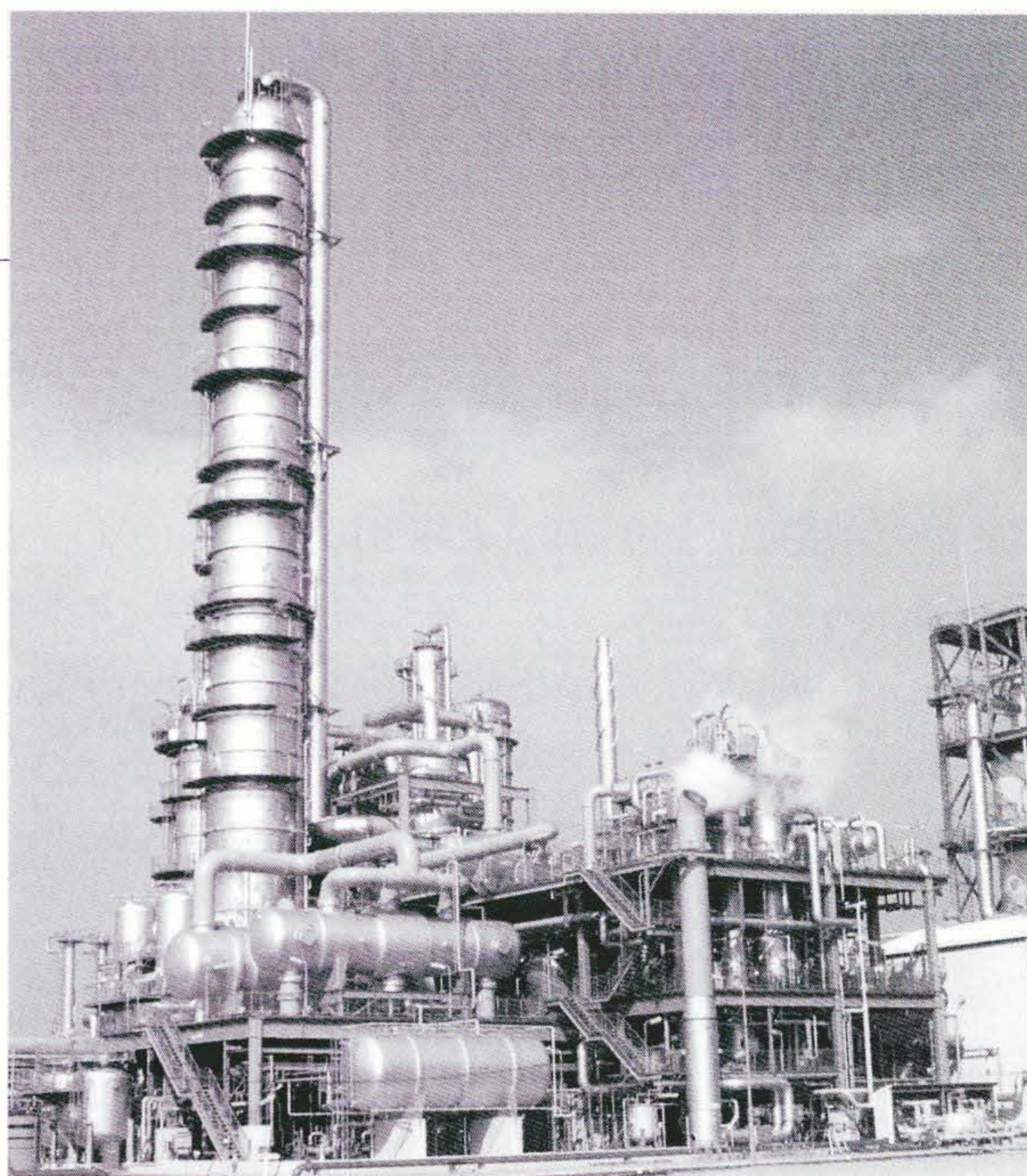
旭化成株式会社水島支社に完成したスチレンモノマープラントの外観
