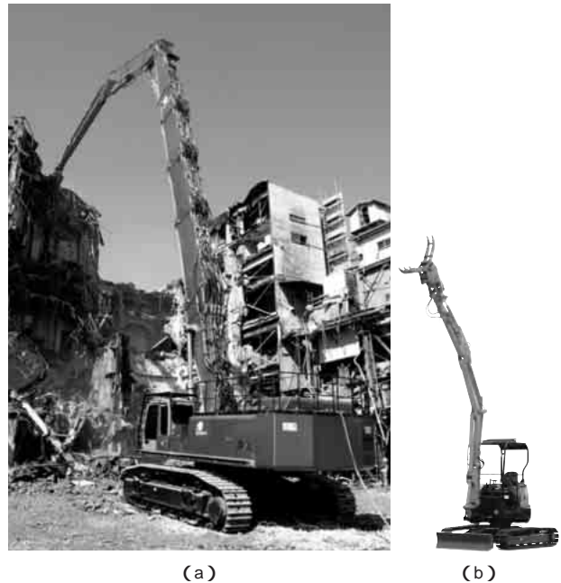
図1 高層ビル解体用のZX1000K(a)と木造家屋解体用のZX35Uミニ木(b)の外観
