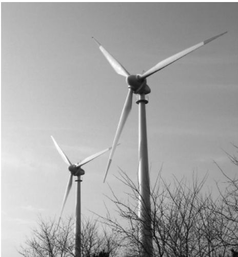
図3 秋田県能代市の落合風力発電所の風車部の外観 ドイツのエネルコン社製のE40型(600 kW)を2台建設した。
