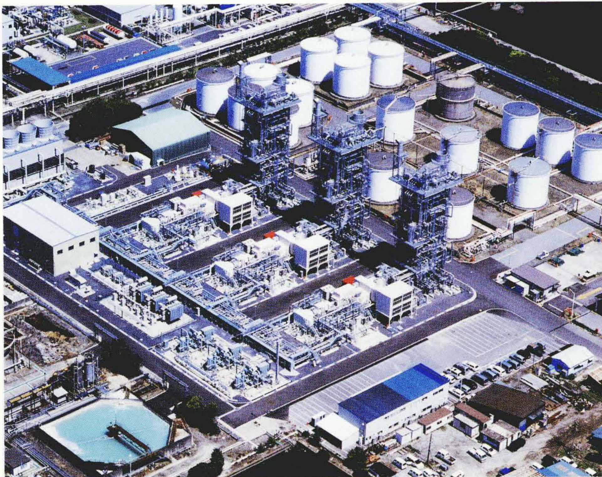
五井コストエナジー株式会社五井発電所の外観
