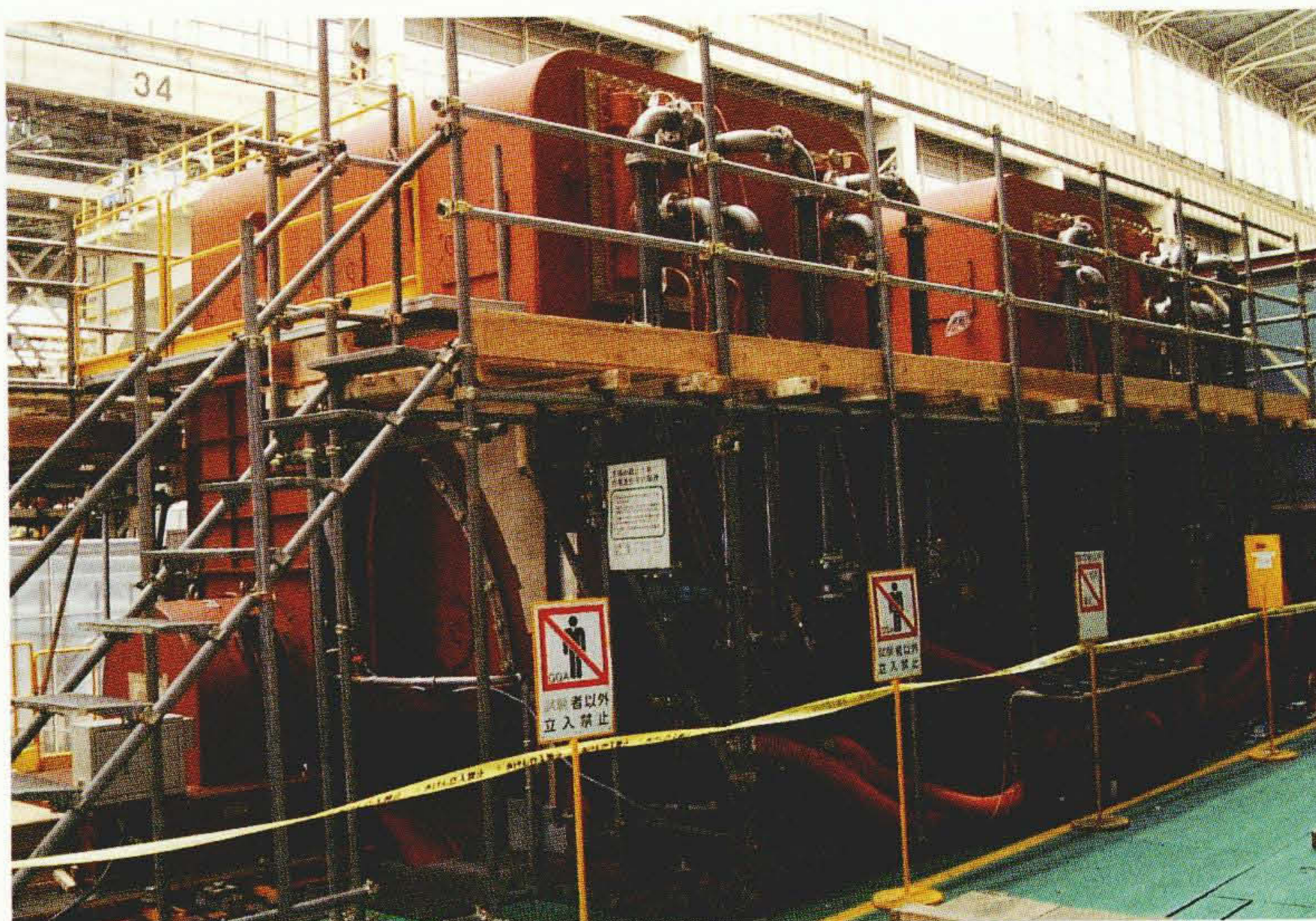
発電機工場での回転試験の様子
