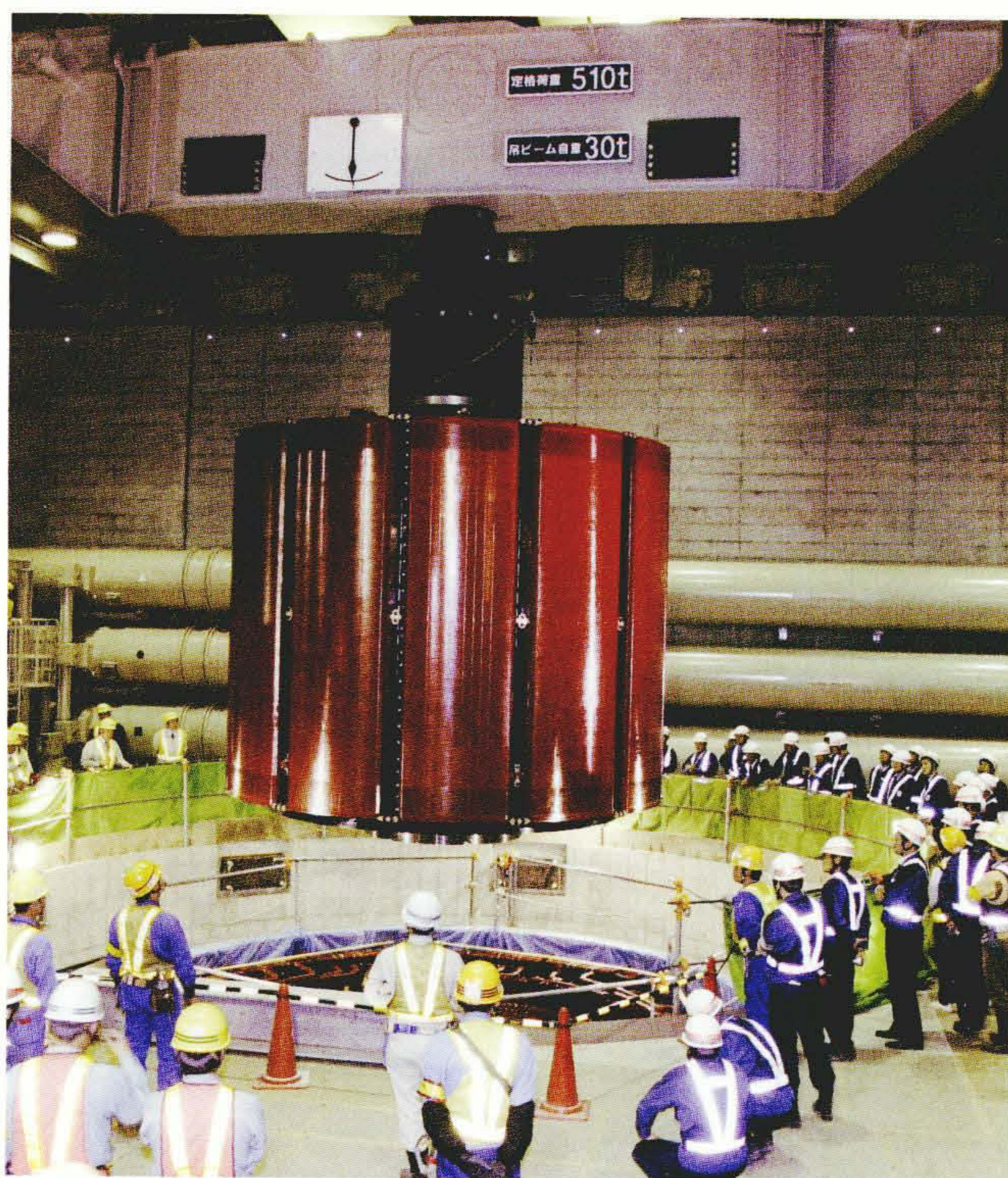
東京電力株式会社神流川発電所納め525 MVA/464 MW発電電動機の回転子
