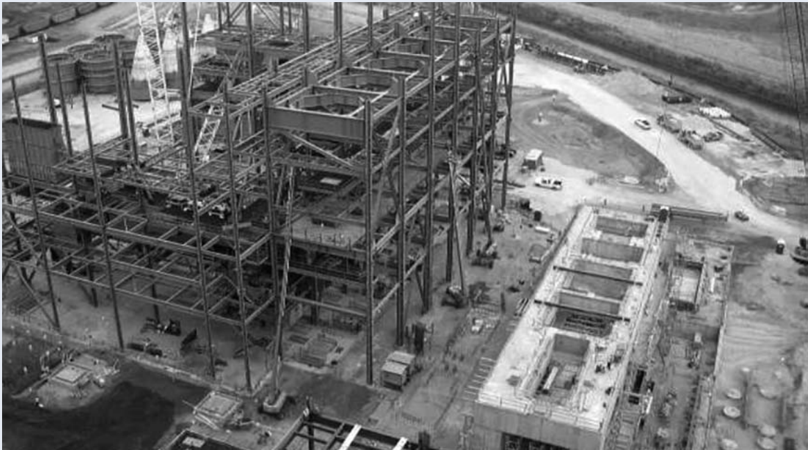
建設中のミッドアメリカーン・エナジー社カウンシルブラッス発電所4号機の全景
