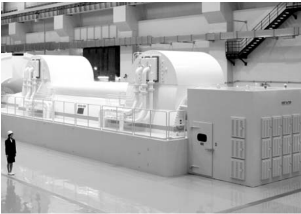
図4 完成した1,570 MVA発電機の外観
