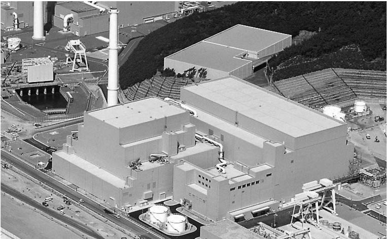
中部電力株式会社浜岡原子力発電所第5号機の全景
