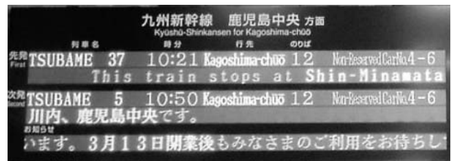
図2 新八代駅改札口の発車標表示例 先発列車、次発列車の愛称名、号数、出発時刻、行き先、乗り場、自由席、停車駅などの表示例を示す。
