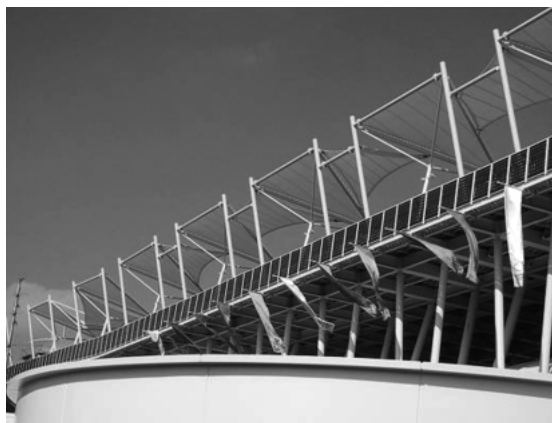
愛知万博新エネルギー・産業技術総合開発機構(NEDO) 実証研究設備
