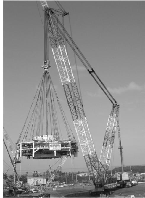
図8 RCCVモジュールの据付け状況
