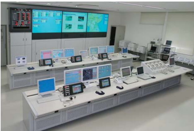
杵藤地区広域市町村圏組合消防本部通信指令室の高機能消防指令施設
