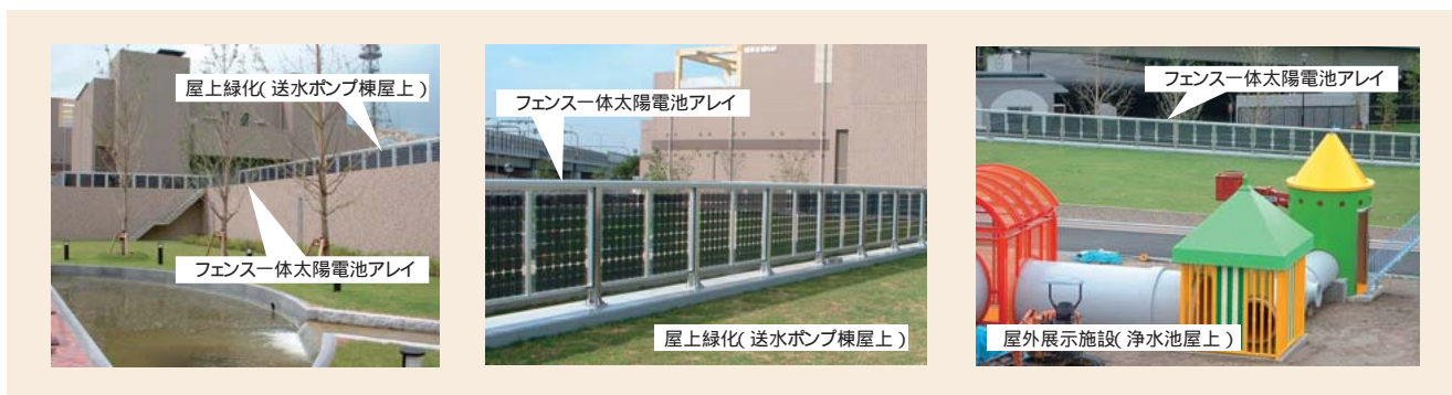
フェンス一体型両面受光太陽光発電設備
