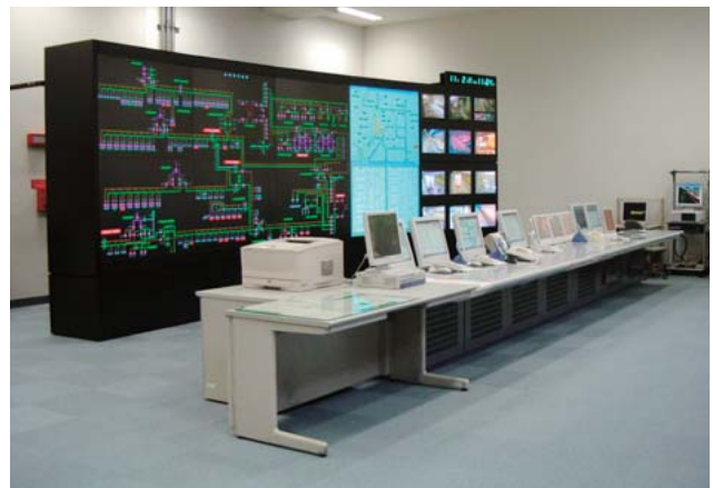
首都高速道路株式会社西東京管理局三宅坂施設管制室納め東京西地区施設防災システム
