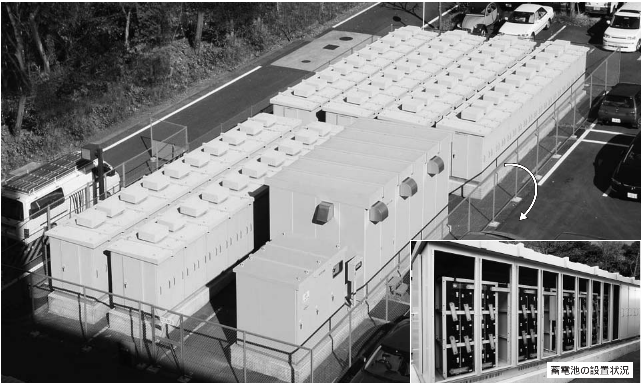
図1 ESCQ Energy Service Company 事業として株式会社小松製作所研究本部に導入した電力負荷平準化用の鉛蓄電池 蓄電池寿命は15年、蓄電池容量4,320 kWhの大容量鉛蓄電池を用いて電力負荷平準化を行い、契約電力400 kWの削減を図る。
