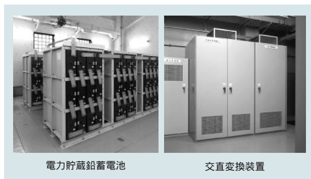
図6 電力貯蔵システム 非常用電源も兼用する定格出力150 kVAの電力貯蔵システムを示す。
