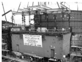
[ 13 ] 制御棒水圧制御ユニット室モジュール
