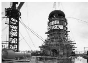
[2] 東京電力 福島第一原子力発電所1号機 原子炉格納容器据付
