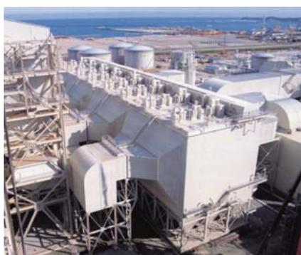
16 移動電極型電気集塵装置「MEEP」の外観(左)と概要(右)
