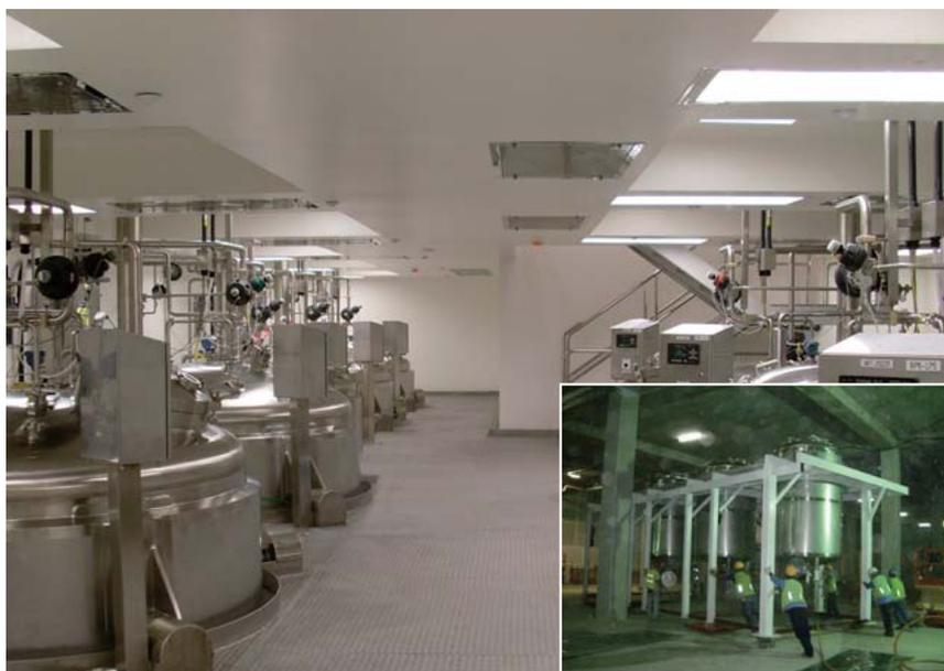
10 完成したバッファ保存モジュールとエアベアリングを使用して搬入中の小ブロック(右下)
