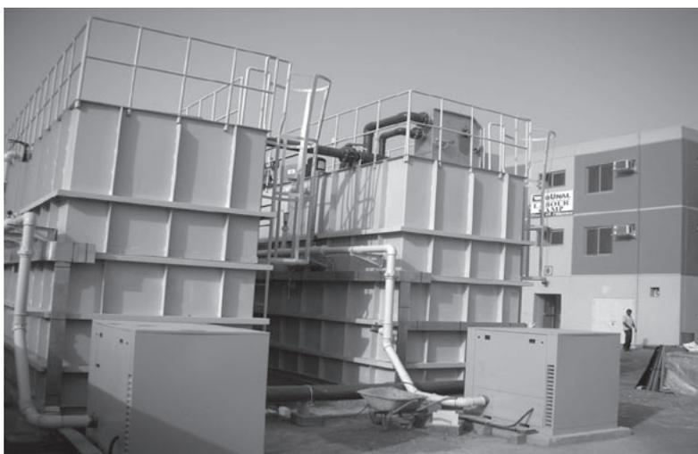
図6 中東・ドバイに納入したMBR (Membrane Bio-reactor) システム
