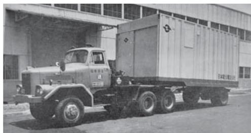
[5] トレーラ式クロスバ交換機 (C22型交換機)
