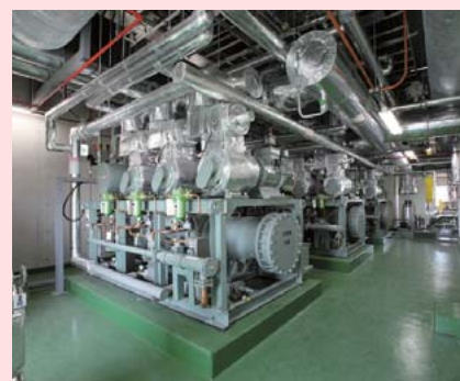
9 株式会社小松製作所建設機械用低温試験室冷凍設備の主な仕様(上)、低温試験室(左下)と冷凍機機械室(右下)
