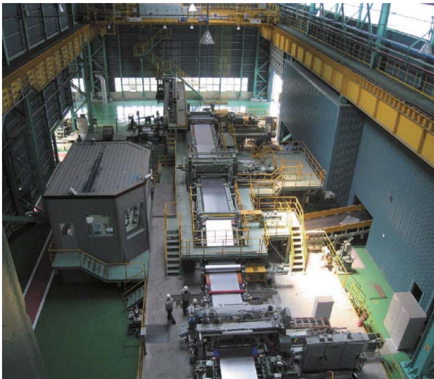
6 Union Steel Co., Ltd. 第5連続溶融亜鉛めっき設備「5CGL」(入側)
