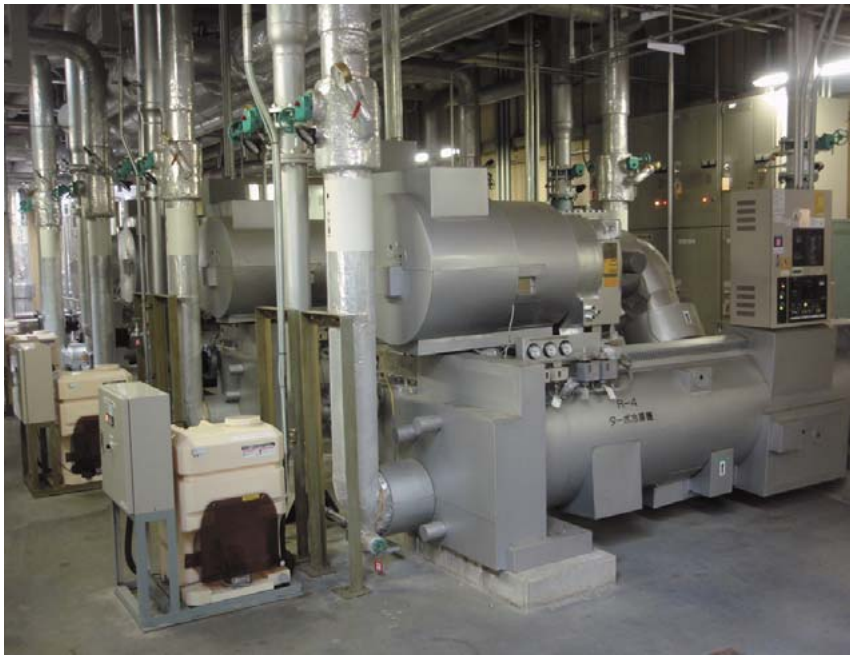
17 日立電線株式会社高砂工場のターボ冷凍機
