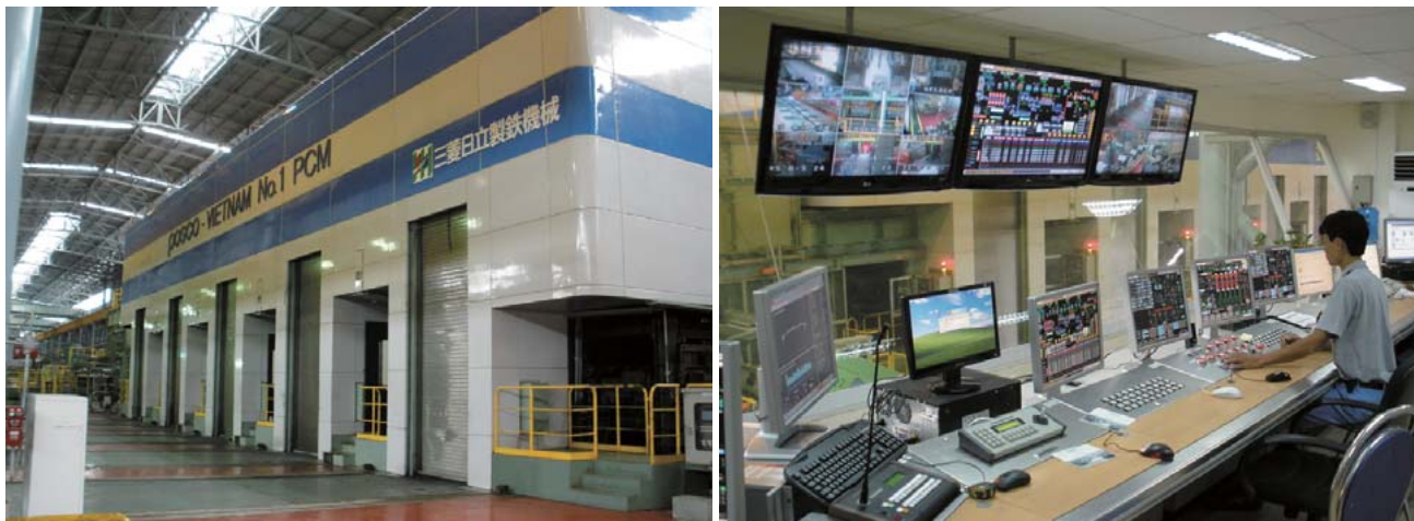
2 酸洗連続冷間圧延設備「V1C」の外観(左)と運転室(右)
