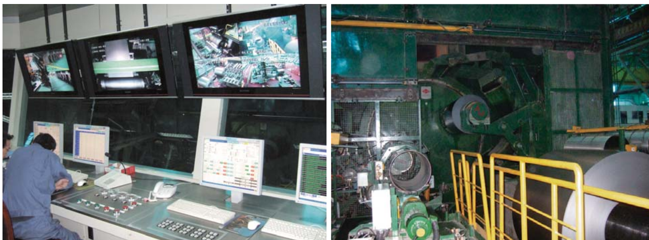
3 酒泉鋼鉄(集団)有限責任公司広幅酸洗連続冷間圧延電気設備の運転室(左)とコイル払出設備(右)
