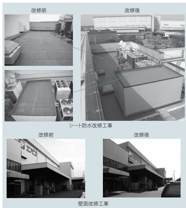
図5 ユーティリティ設備改修と同時期に実施した建物の改修工事の実施例 建物の長寿命化のための保全工事として、シート防水改修工事と壁面改修工事を行った例を示す。
