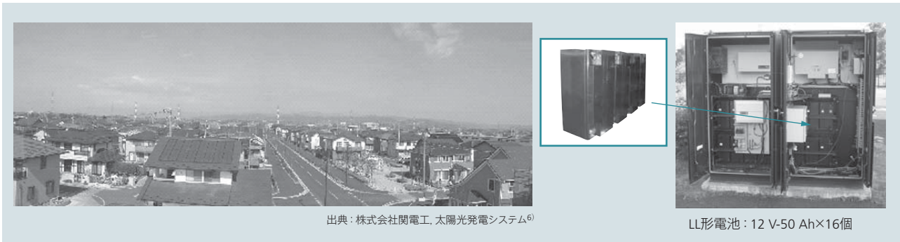
図4 LL形電池の使用事例（集中連系型太陽光発電システム実証研究 3), 4)
