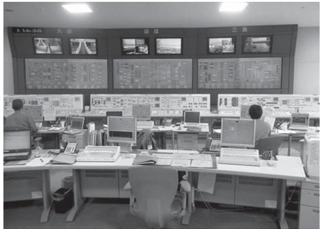
図6 | 大阪府庭窪浄水場の統合遠隔監視制御システム
