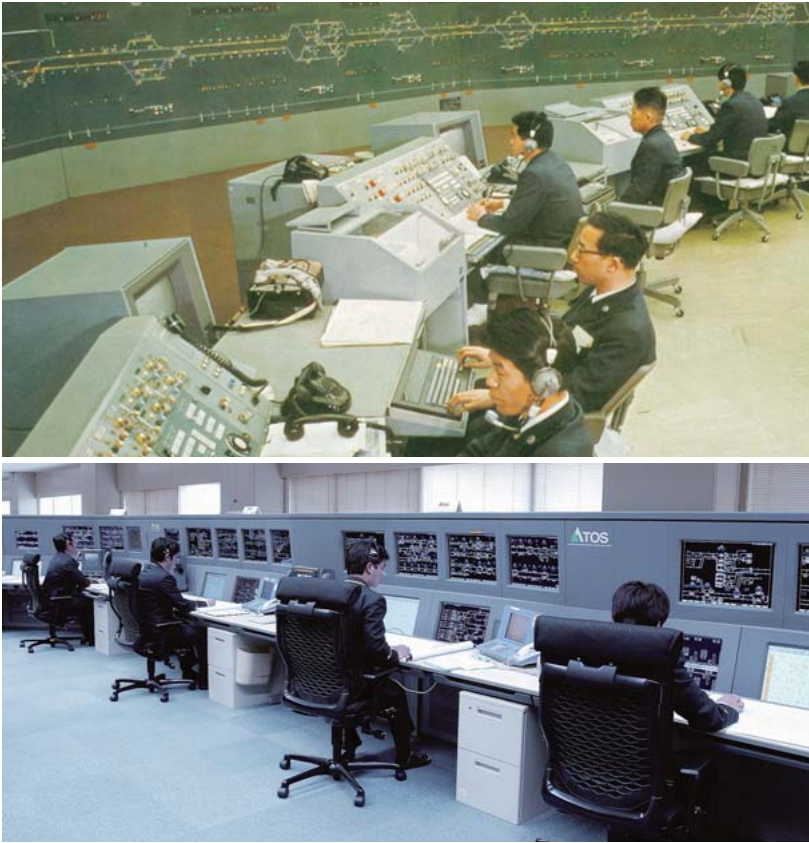
列車運行管理システム「COMTRAC」(上)と、東京圏輸送管理システム「ATOS」(下)。
