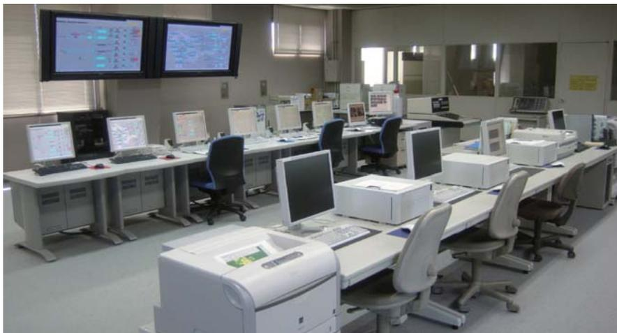
3 柏市水道部 中央監視制御システムの制御室
