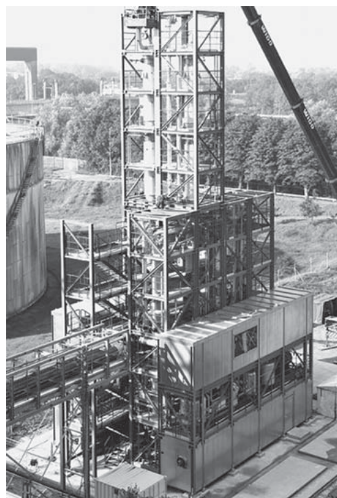
図2 | 5,000 m 3 N/hパイロット装置の外観
