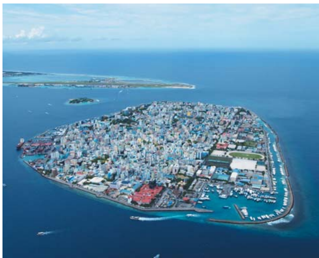
インド洋に浮かぶモルディブ共和国のマレ島。この島をはじめとする七つの島で、日立グループは上下水道運営事業を行っている。
