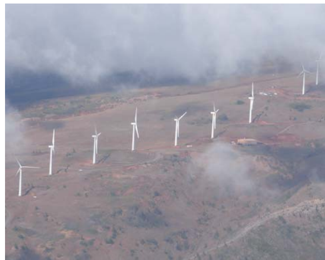
ハワイ・マウイ島でのスマートグリッド実証。比較的電力コストが高いとされる離島では、再生可能エネルギーを効率よく利用することが求められる。
