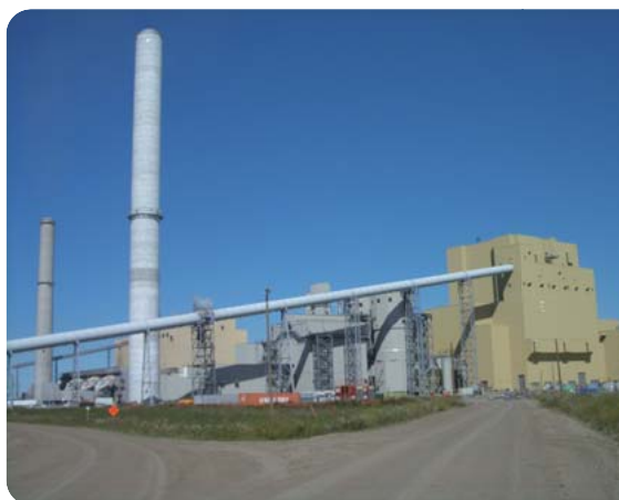
1 カナダ・キープヒルズ発電所3号機
