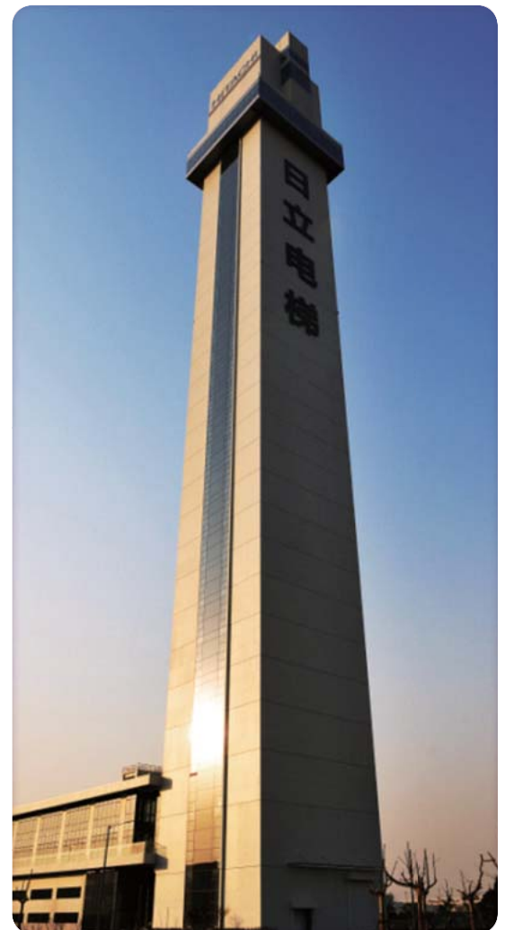
9 日立電梯（上海）有限公司の敷地内に建設した地上高172 mのエレベーター研究塔
