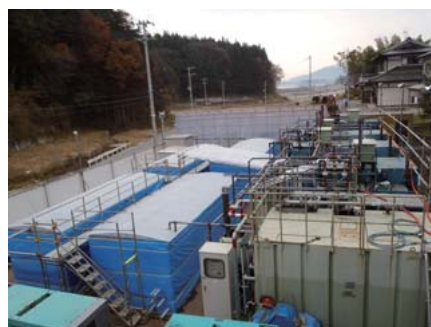
下水処理場の復旧作業（移動式仮設膜処理ユニット MBRで処理を再開した陸前高田浄化センター）
