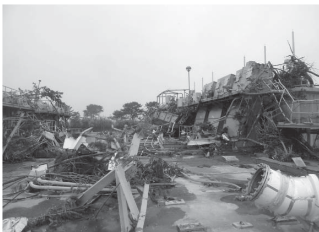
図3 | 被災直後の沈砂池設備（南蒲生浄化センター）
