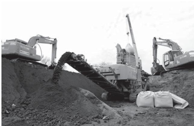
図3 | 復興土木工事に使用される土質改良機などの建設機械
