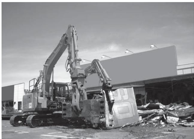
図4 | 保冷車コンテナの撤去作業（石巻市）
