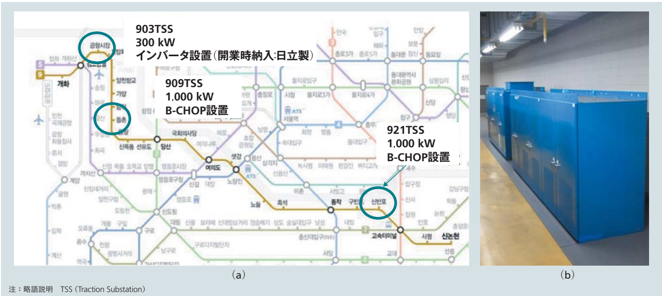
図3 | ソウルメトロ9号線路線図 (a) とB-CHOPの外観 (b) 今回のB-CHOP導入サイトと921変電所で稼働開始したB-CHOPの装置外観を示す。909, 921駅ともに地下駅である。装置 (b) は、左奥からチョッパ盤 (フィルタ盤列盤構成)、蓄電池盤である。
