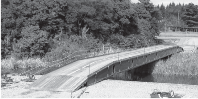
図5 | 橋梁構築状態
