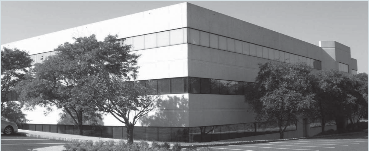
米国ニュージャージー州にある日立パワーシステムズアメリカ社
