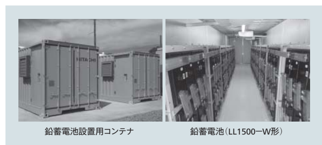
図7 | 米国ニューメキシコ州ロスアラモス郡に設置された鉛蓄電池システム「米国ニューメキシコ州における日米スマートグリッド実証」において設置している鉛蓄電池システムの外観を示す。
