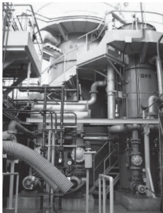
図6 | フッ素高度処理装置
