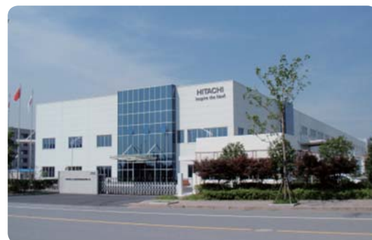
7 中国の脱硝触媒工場の外観
