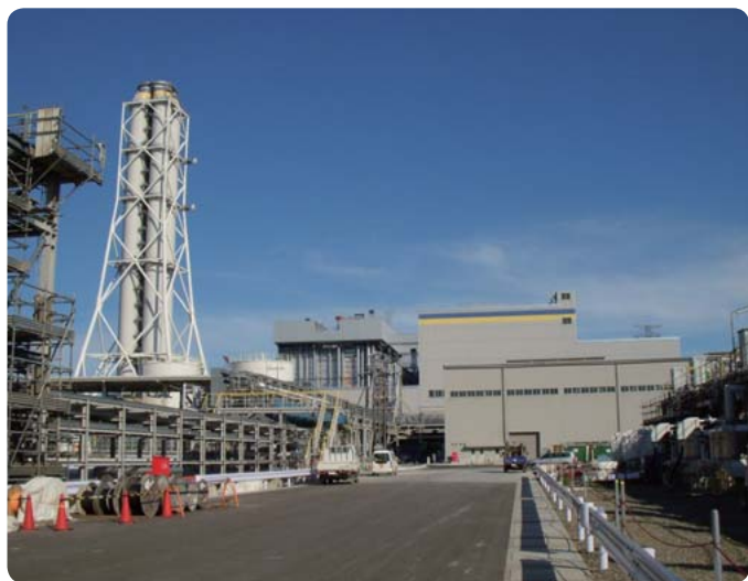
2 中部電力上越火力発電所1-1号のタービン建屋
