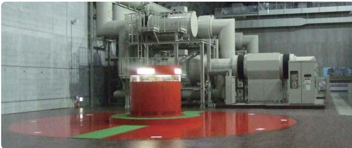
1 東京電力 神流川発電所2号発電電動機（揚水運転中）
