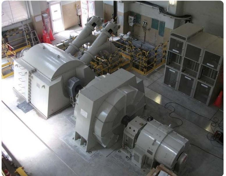
5 中部電力 和合発電所のペルトン水車および発電機
