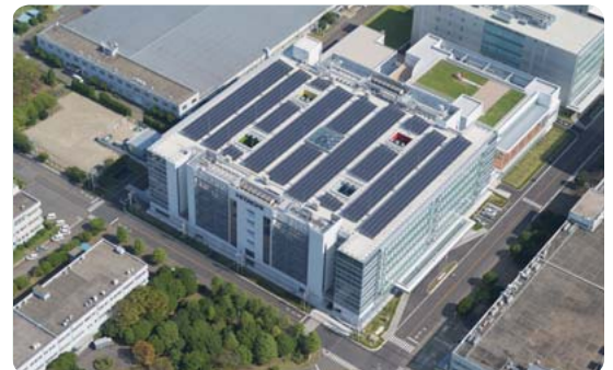
4 両面受光型太陽光発電システムを設置した横浜事業所新設事務棟の屋上
