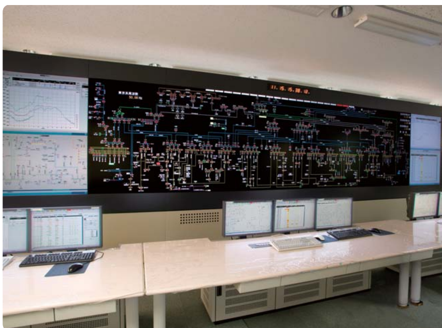
3 東北電力 新潟系統給電指令所システム (仮設置にて調整中の系統監視盤と指令卓)
