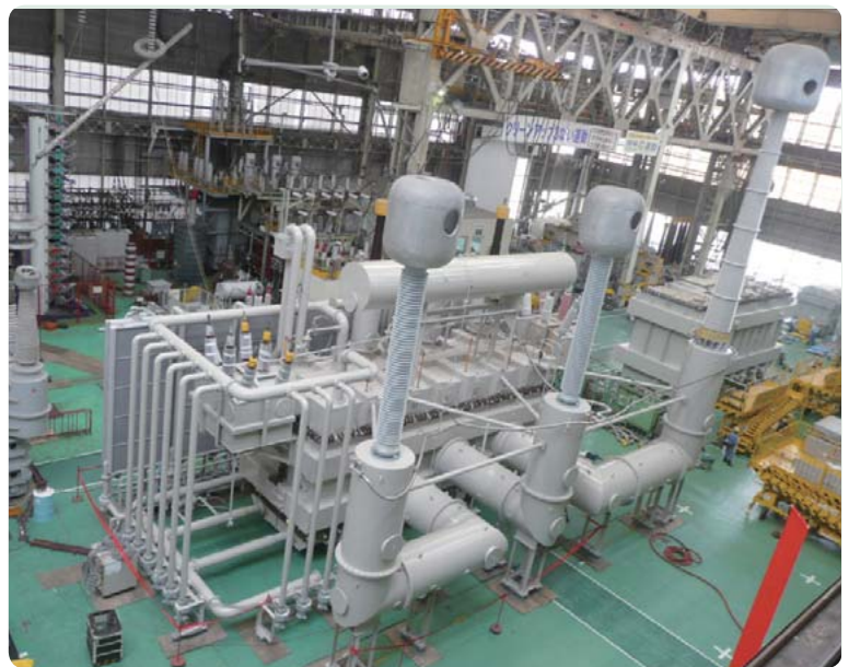
8 次期500 kV分解輸送変圧器の実規模モデル試験（分解前試験）の様子
