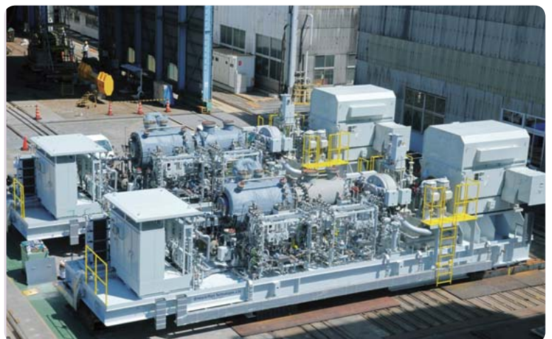
21 FPSO用プロセス遠心圧縮機
