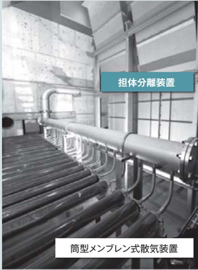
図4 | 好気槽内部の施工（新2系）
