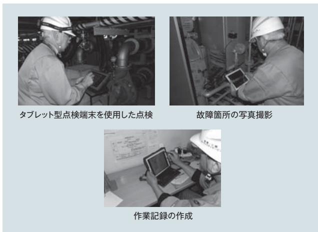
図4 | タブレット型点検端末を使用した巡回点検
