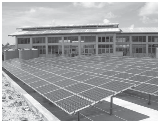
図5 | ツバル向け太陽光パネル
