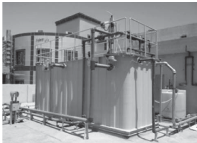
図3 | 病院向けコンパクト膜型下水処理システム イラク・バスラ市内の病院に納入したコンパクト膜型下水処理システムを示す。処理水量は120 m 3 /日である。
