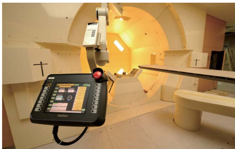
分子追跡陽子線治療装置が導入された治療室（施工完了前）。病院スタッフの使い勝手にも配慮されている。
