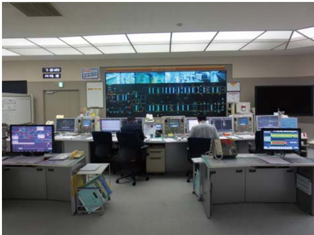
6 有楽町線・副都心線運行管理システム指令室内装置
