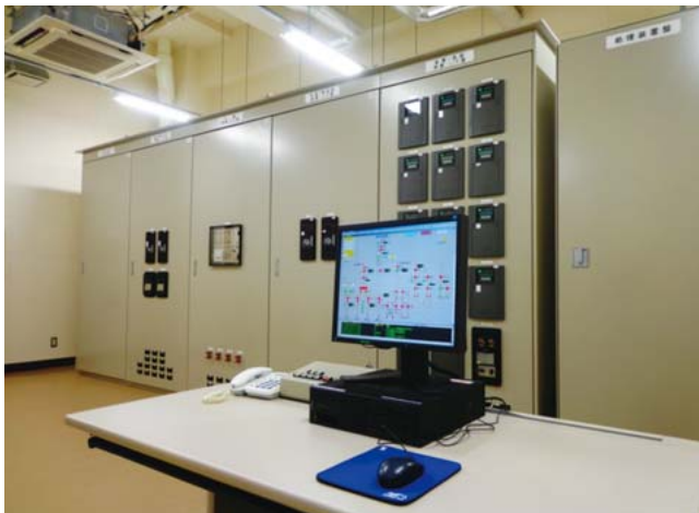
3 移動型変電所（上）、電力管理システムと保護インターフェイス盤（下）
