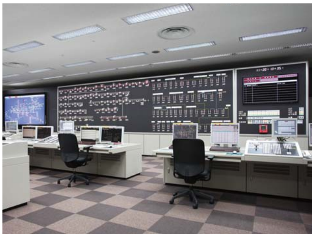
8 新システムへの切り替え後の電気指令所
