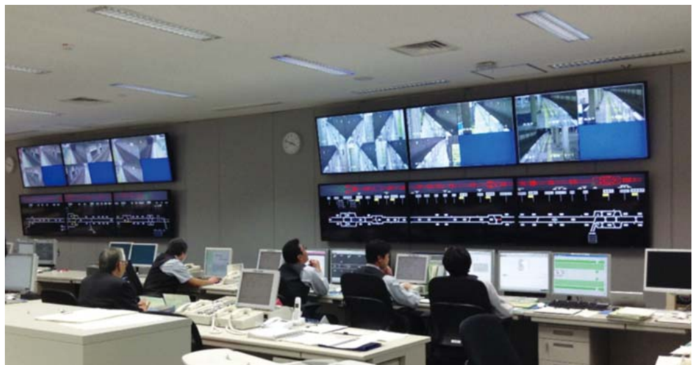
5 東京都交通局 都営地下鉄4路線列車運行制御システムの運行表示盤と指令卓
