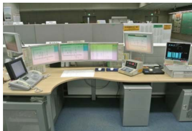
10 新設備指令システムの指令室と操作卓
