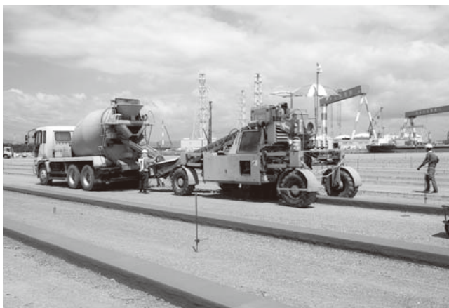
図8 スリップフォーム工法による施工の様子
