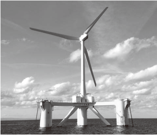
図8 | 福島沖浮体風車の全景
