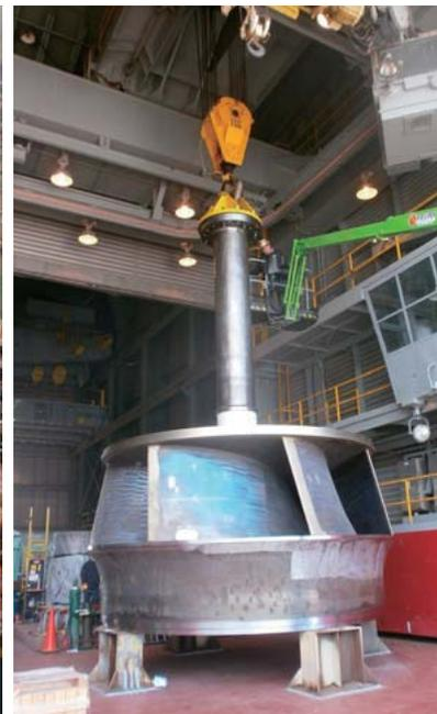
1 ニューヨーク州電力公社ナイアガラパワープロジェクトの全景（上部がルイストン発電所）（左），現地組み込み中の新型ポンプ水車ランナ（右）
