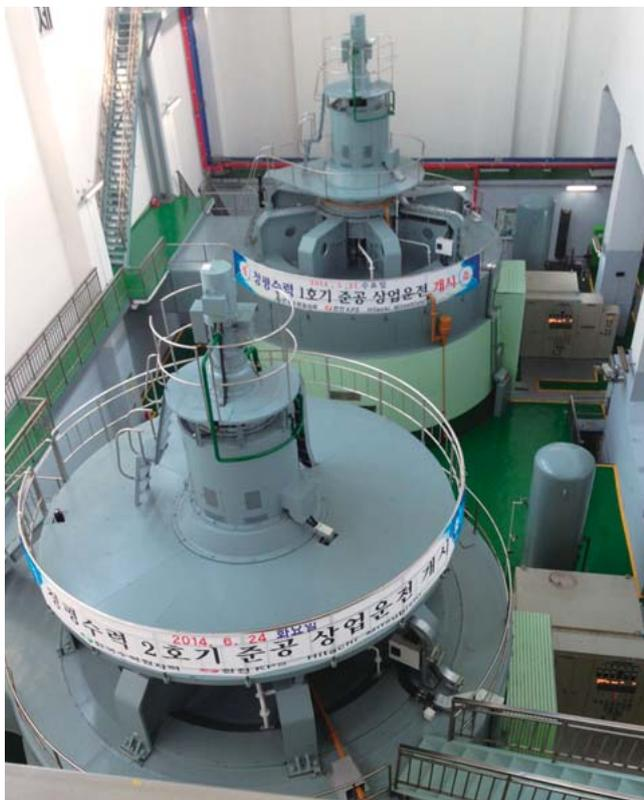
2 大型オーバーホール実施後の韓国水力原子力発電会社清平発電所の1号機（奥）と2号機（手前）
